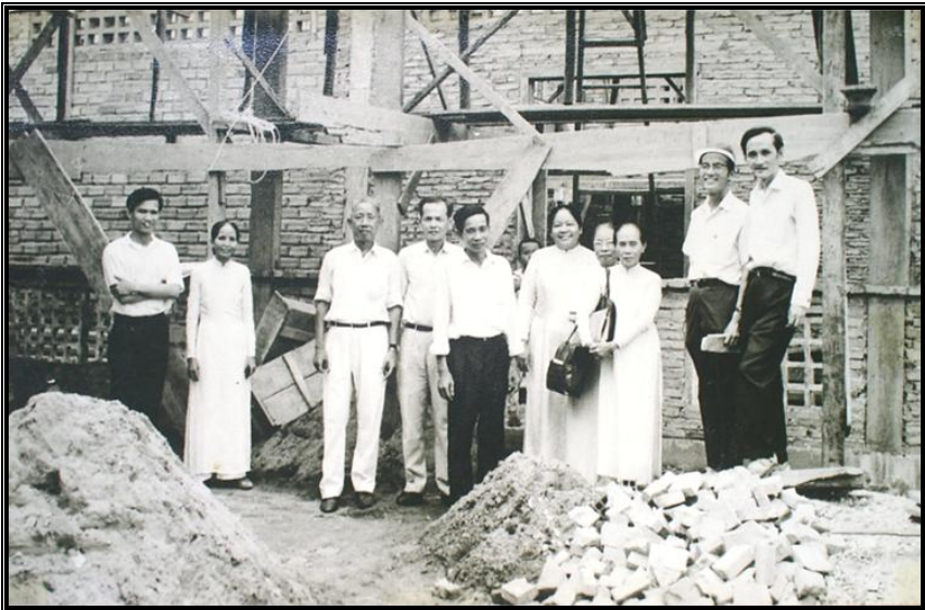
Đạo trưởng Chí Tín (ngoài cùng bên phải) tại nơi xây dựng trụ sở Cơ Quan
